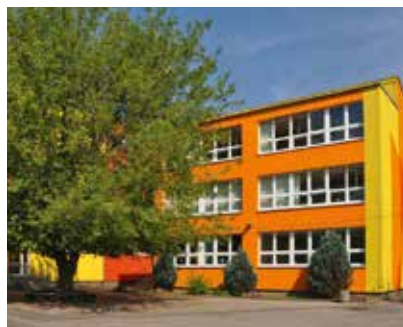
Sanierte Grundschule „Thomas Müntzer“ in der Lutherstadt Eisleben Foto: Lutherstadt Eisleben
